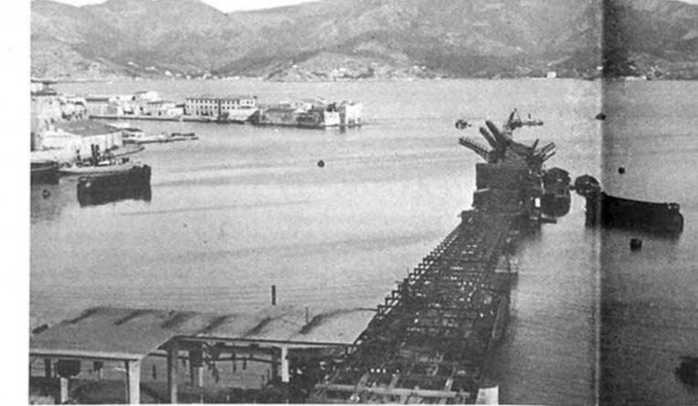
Il "Ponte Hennin" che serviva per lo scarico del carbon coke per il funzionamento degli Alti Forni
