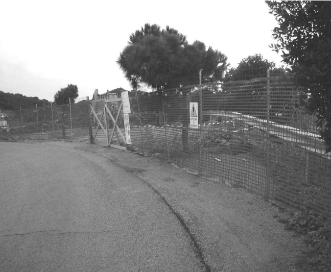
Recinzione dello spazio del Puntale che il Parco aveva attrezzato
