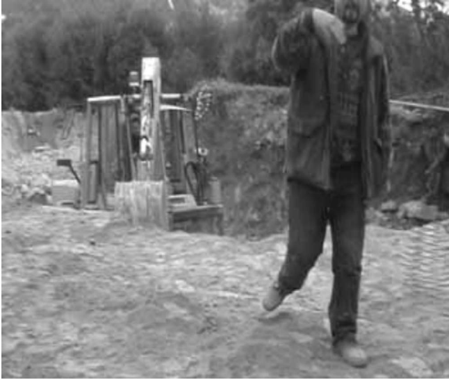
Lavori di scasso al Puntale dell'Acquaviva (da Elbareport)
