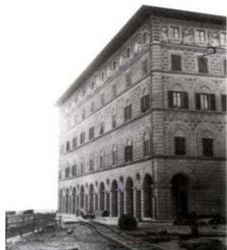
Palazzo per gli uffici amministrativi degli altiforni (1904) - foto d'epoca
