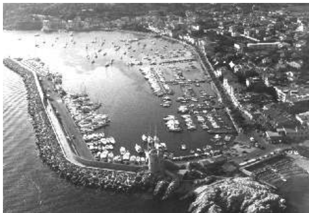
Veduta aerea del porto e del lungomare di Mrciana Marina (foto C.V.M.M.)
