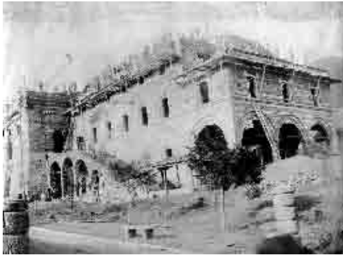
Casa padronale di S. Martino in costruzione (1902 - 1904)
