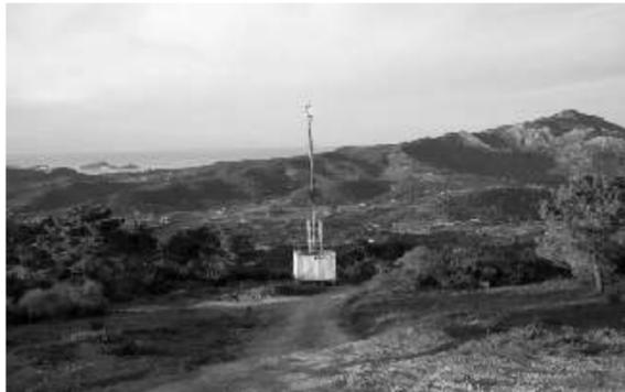
Si tratta di veri e propri container su ruote, con tanto di targa automobilistica, dotati di una antenna di circa 20 metri e che, con la scusa della precarietà e mobilità, vengono rapidamente piazzati in zone abitate o di particolare pregio paesaggistico dove altrimenti sarebbe difficile instal-
