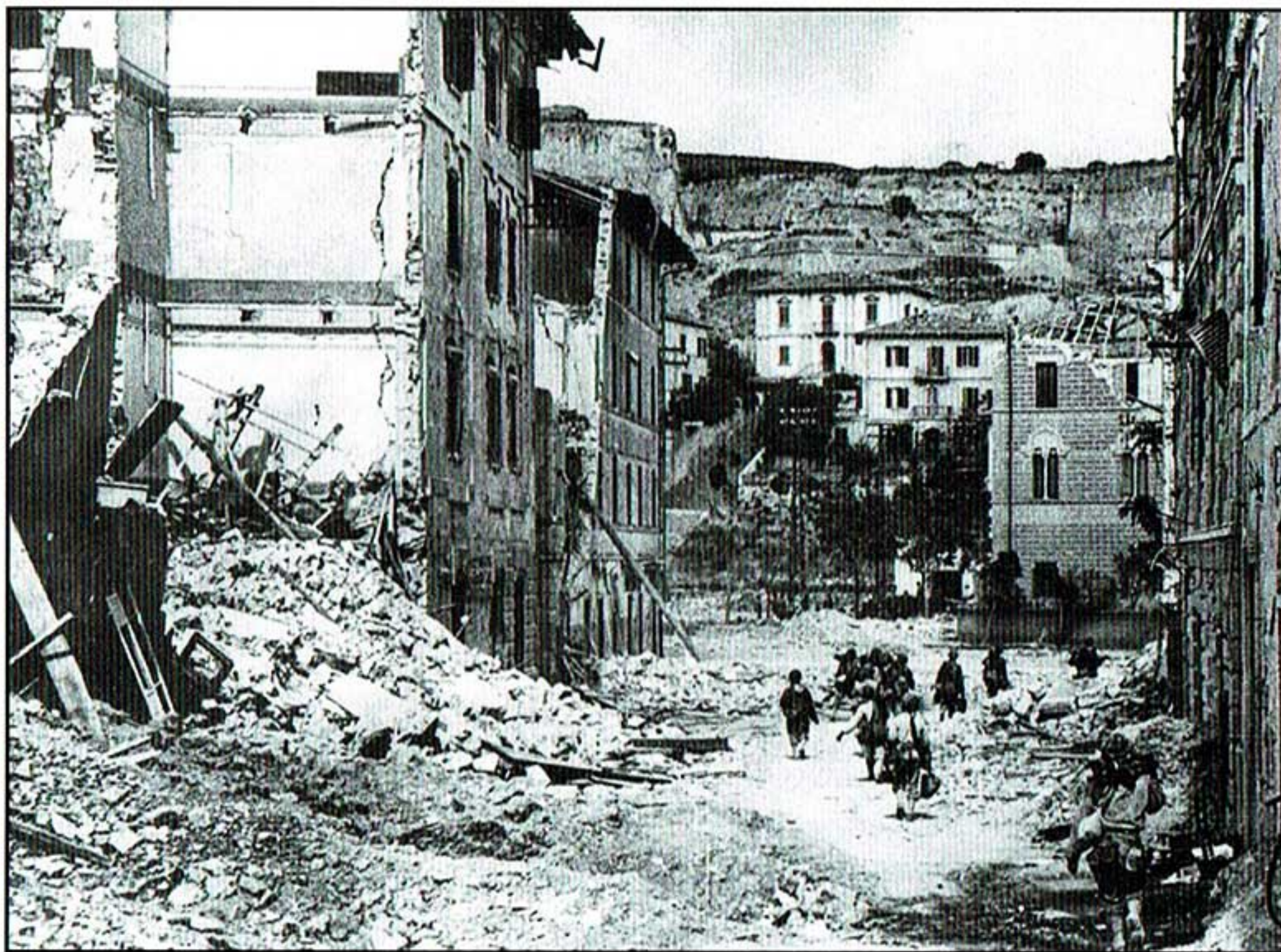
Portoferraio – Fine Giugno 1944 – Macerie delle case distrutte dai bombardamenti nella zona del Ponticello
