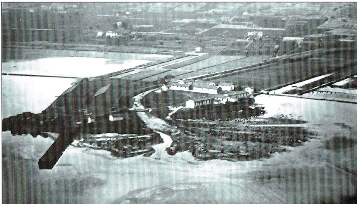
Veduta aerea dell'idroscalo. Il pontile in legno era lungo ottanta metri e largo cinque, sorretto da quattro stilate di pali di pino del diametro di 30 centimetri. Il tavolato era composto da tavoloni da 8 centimetri. Sui due lati erano costruiti due parabordi. (Ufficio Storico Aeronautica Militare)
