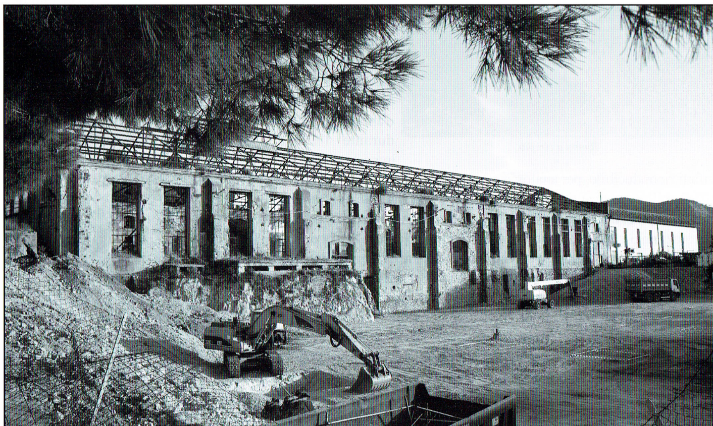
Sbancamento delle pendici ovest della collina di Capo Bianco di dentro per la creazione di parcheggi al servizio del nuovo centro commerciale
