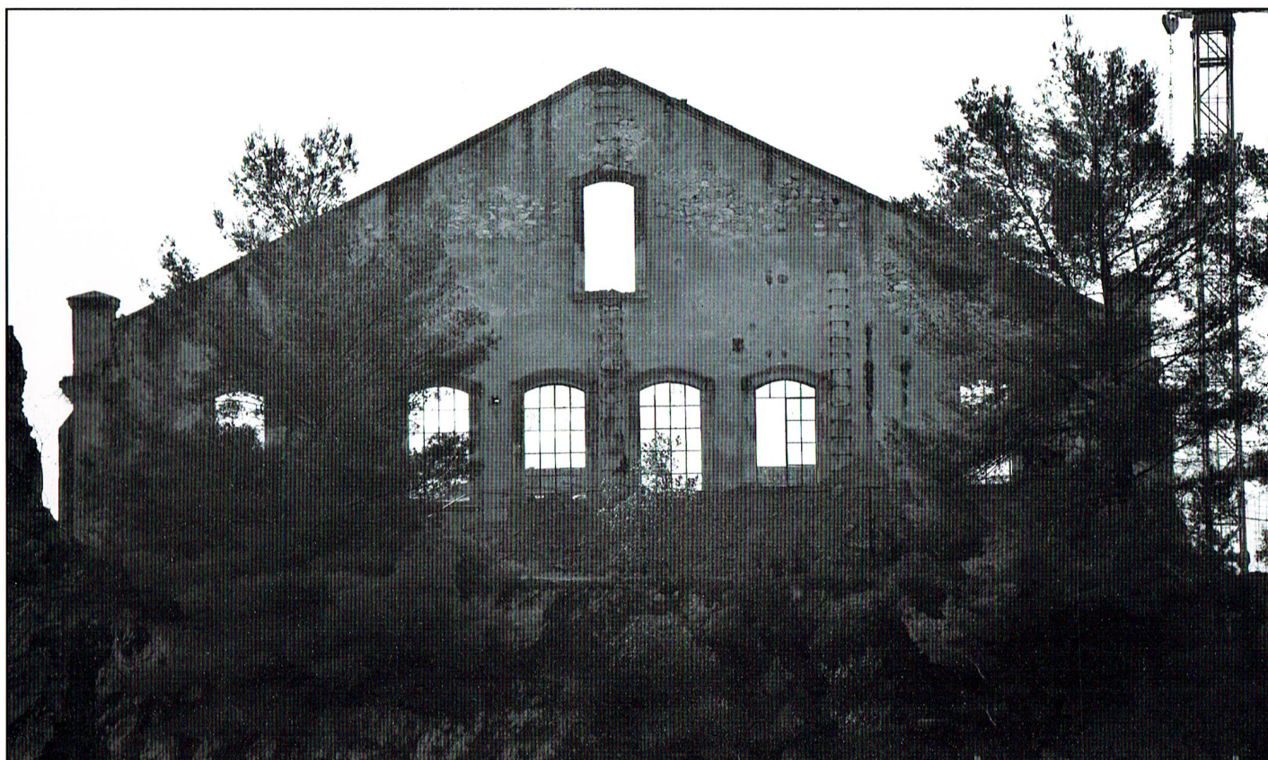
Il frontone dell'ex centrale, prospiciente il parcheggio, prima della sua demolizione avvenuta con gli interventi in corso d'opera
