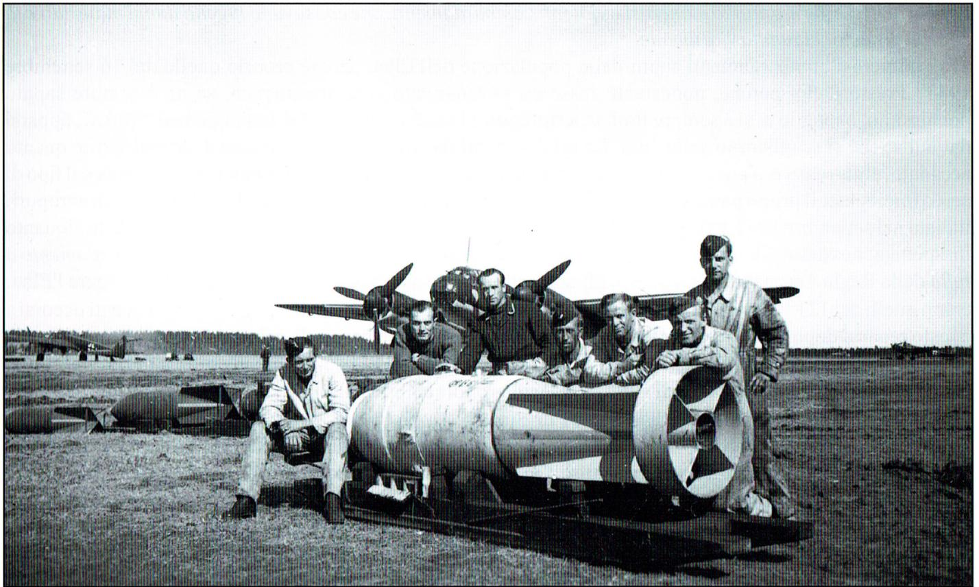
*Personale della Luftwaffe posa intorno ad una bomba SC 1000 "Herrmann". Notare tra le pinne, una delle quattro strisce gialle longitudinali, che stava ad indicare che la bomba era da demolizione con fattore di riempimento di esplosivo dell'ordine del 50%. Sulla sinistra, una SC 250 e una SC 500 nella consueta colorazione verde oliva, con le consuete bande gialle sulla coda. (Collezione R.E.Felli).*
