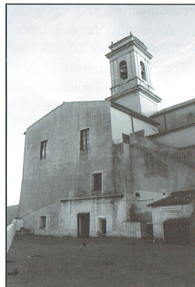
Bastione nord est
