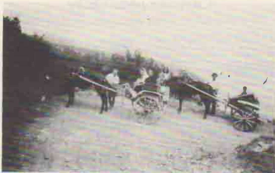
Partenza dal Capannone per Scaglieri
