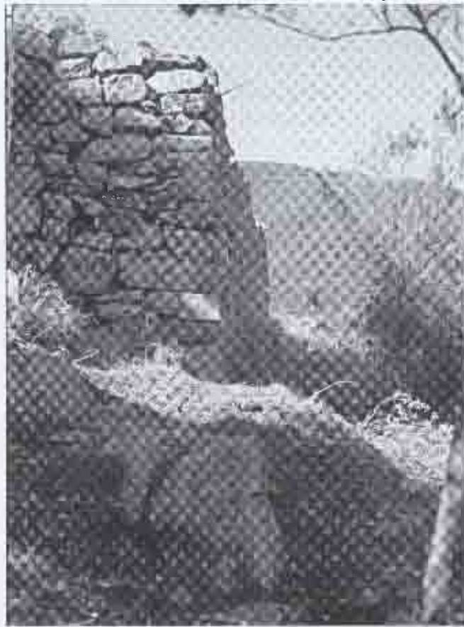
Castiglione di San Martino - Muro di recinzione
